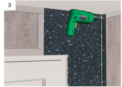
3 Das IP evtl. mit Schrauben / Nägeln befestigen, um zu justieren.
