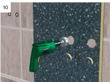
10 Anschlüsse (plus 2 mm für Silikon) mit Bohrer und Kreisschneider ausschneiden.
